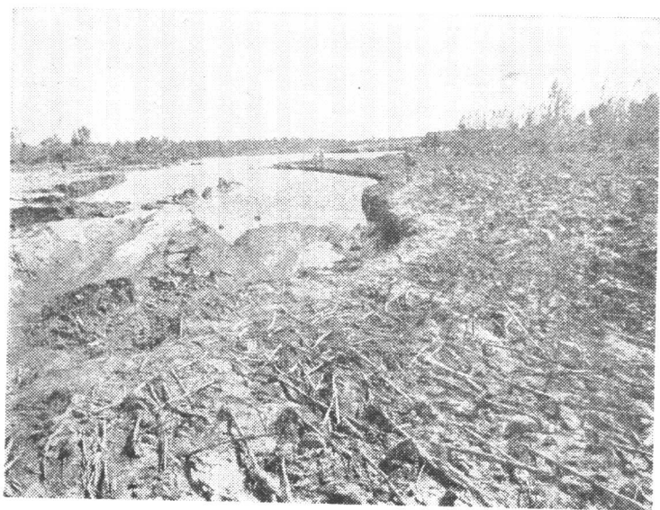
图为辽阳唐马寨堤坝决口处。
