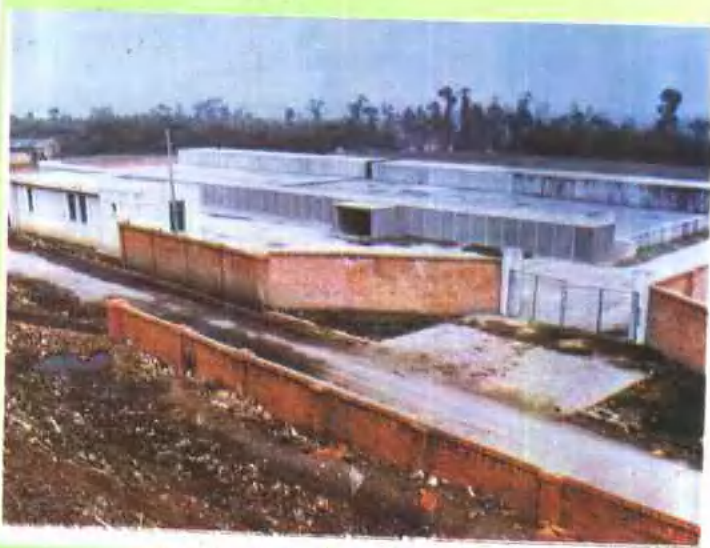
▲1987年建成的沼气储粪池。
