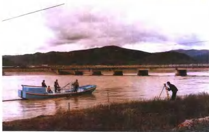
黄河吉迈大桥
