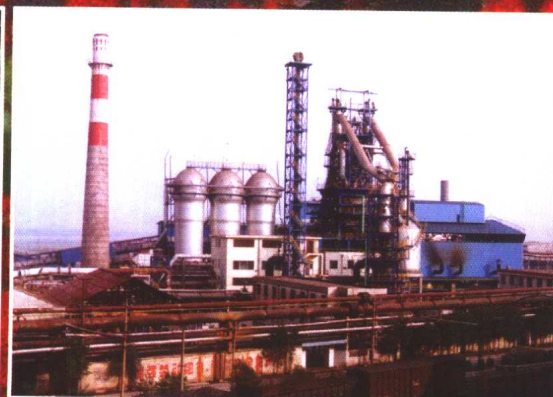
新建的五号高炉
