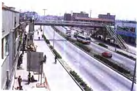
拓宽后的沪南公路 (张建明)
