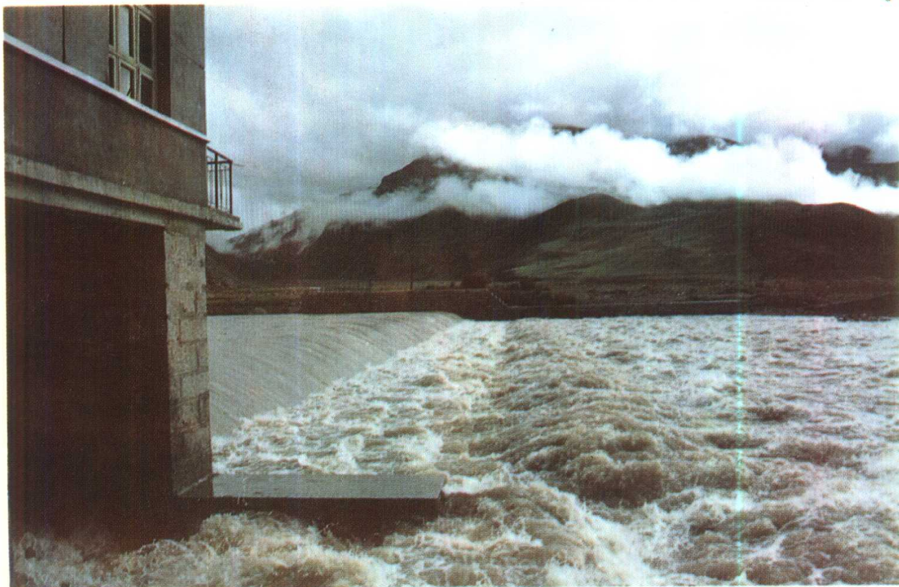
◀ 省母电站拦河坝入水处
