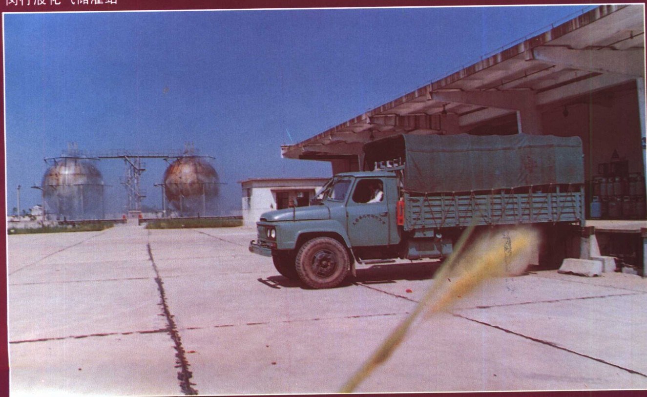
闵行液化气储罐站
