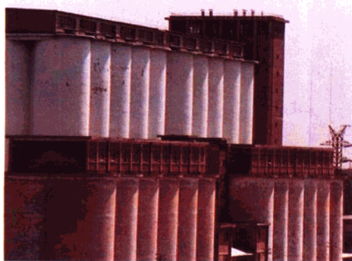
大型钢筋混凝土立筒仓
