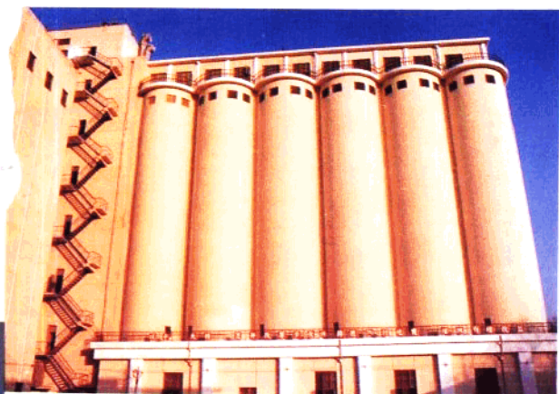
大型钢筋混凝土立筒仓
