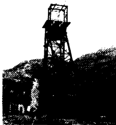
建设中的矿山 开拓延伸工程主竖井 井架。
