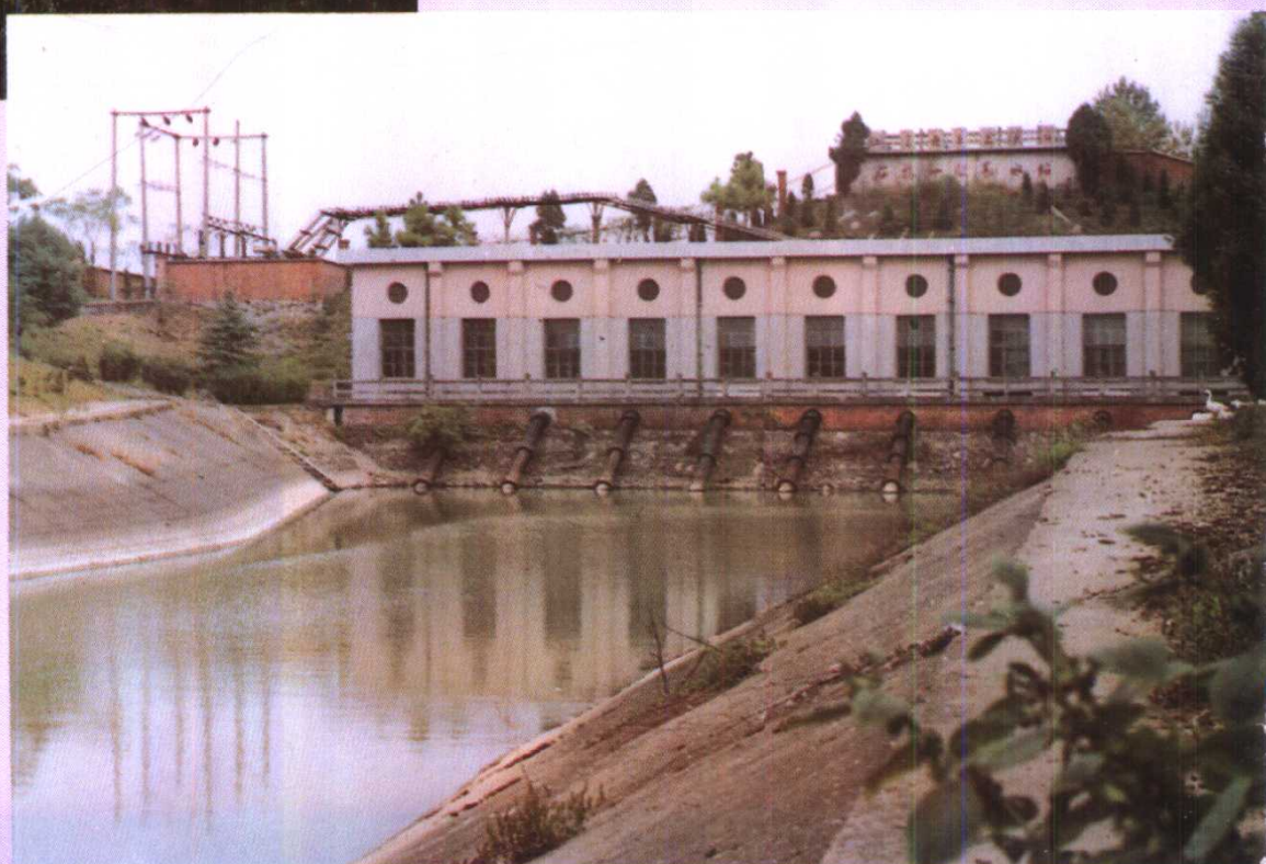
►石桥一级翻水站
