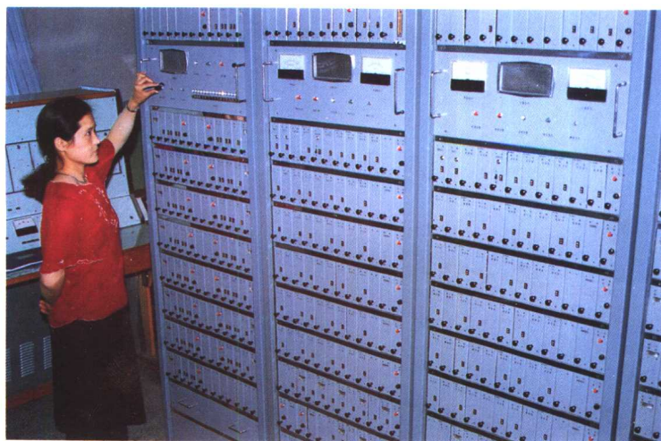
建立在乌鲁木齐县安宁渠区的新疆广播电台 652 收音台机房一角，该台于 1965 年动工兴建，1969 年 10 月竣工。
