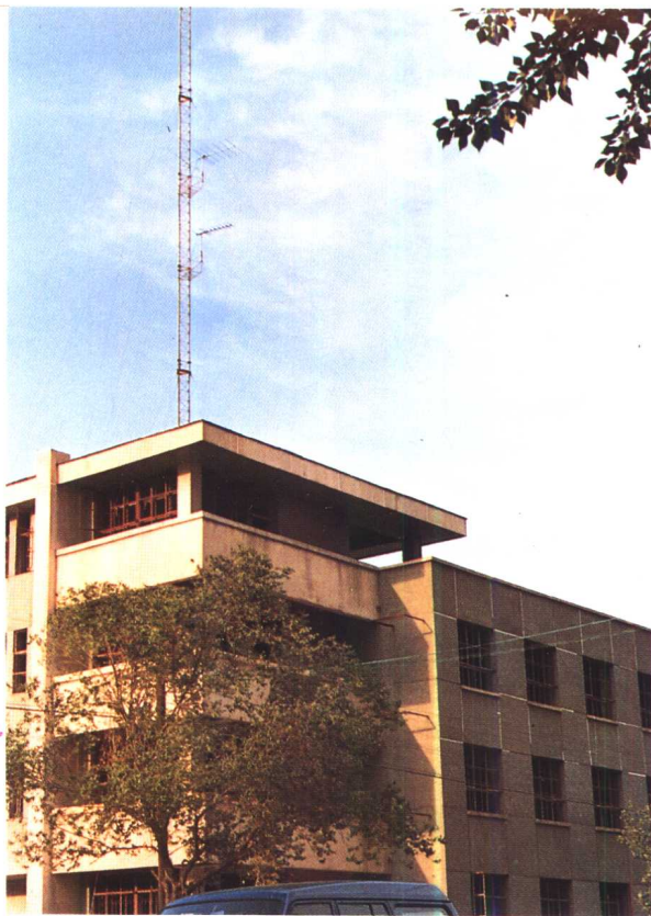
1985 年建成的米泉县广播电视办公楼。
