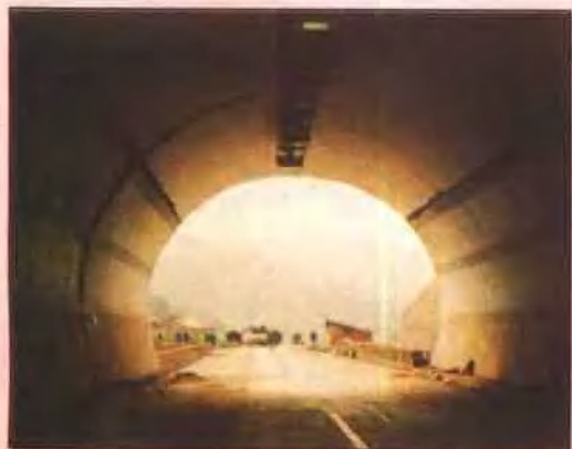
▲建设中的成都高等级公路上的龙泉山隧道
