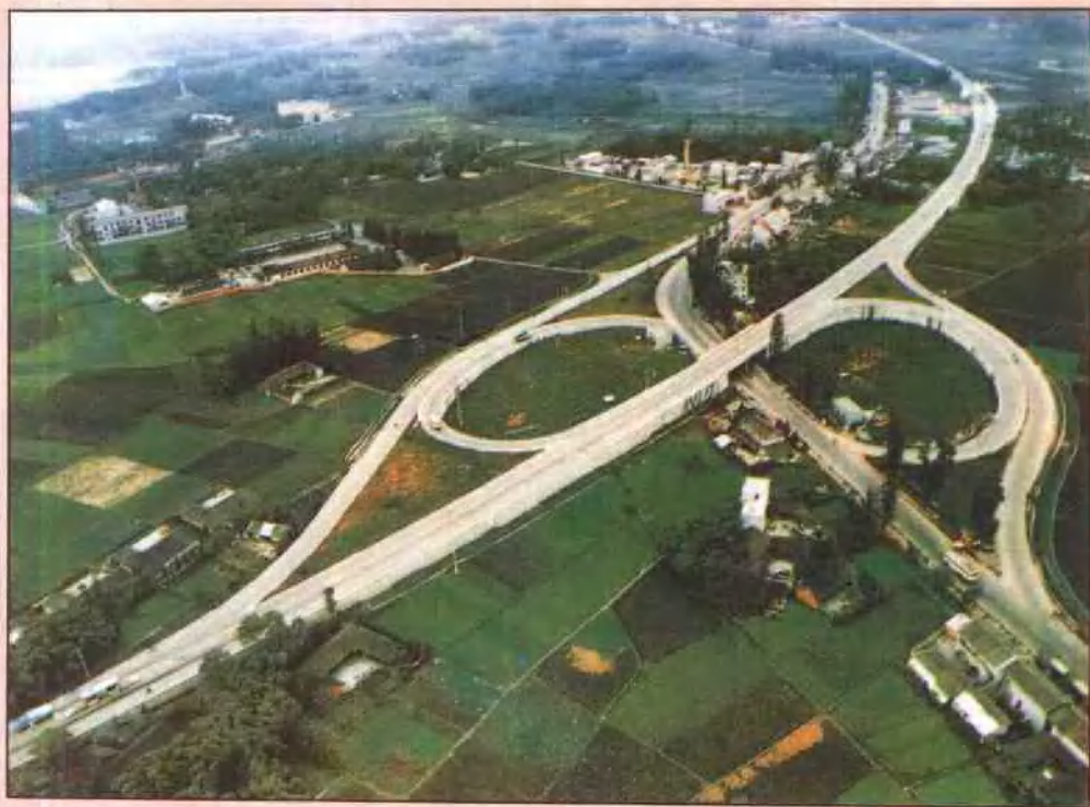
►新津蔡湾立交桥 (川藏公路与大件 路立交)
