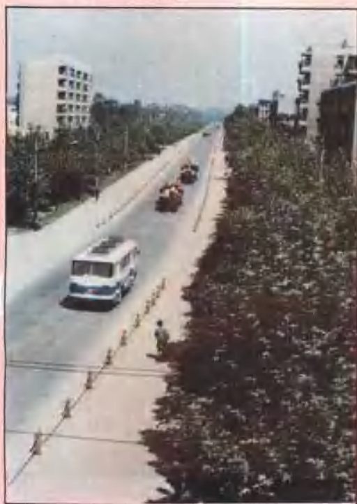
▼成都市第一条一级公路川陕公路 驷马桥—天回镇段
