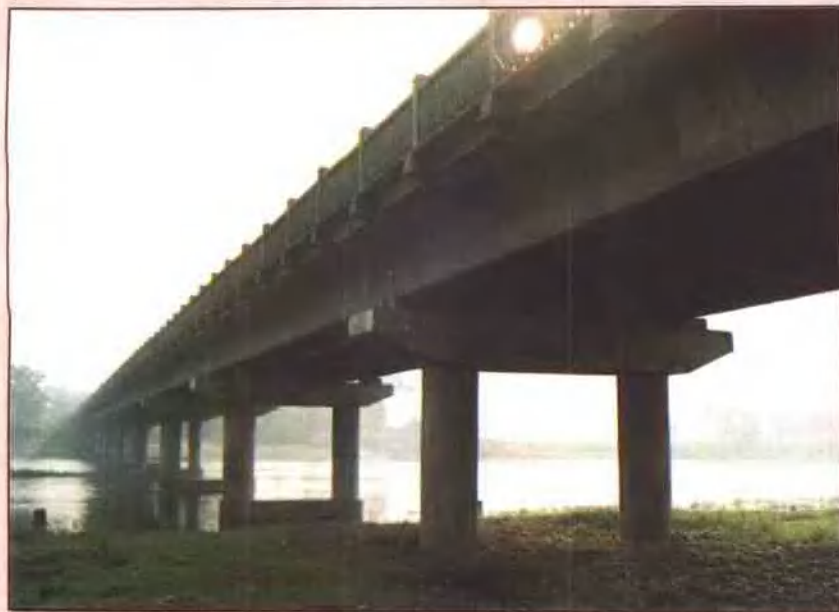
◀成都县道公路上最长的大桥—— 新津龙王渡大桥
