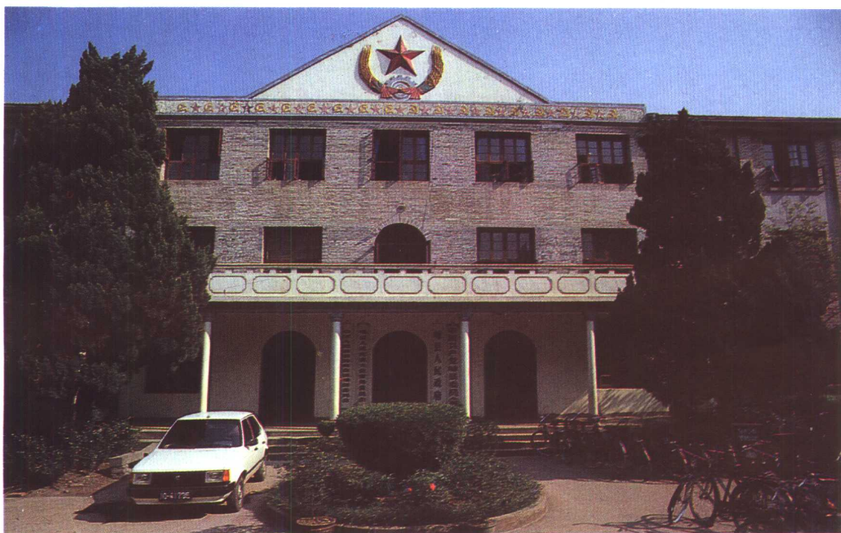
县级机关办公楼
