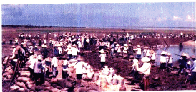
金浦县民工为灾民和解放军 修筑工事，并修筑加固江堤 防海风
