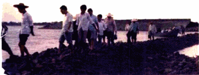
自治区党政领导赴东兰县生产救灾第一 线，主持防汛抢险工作
