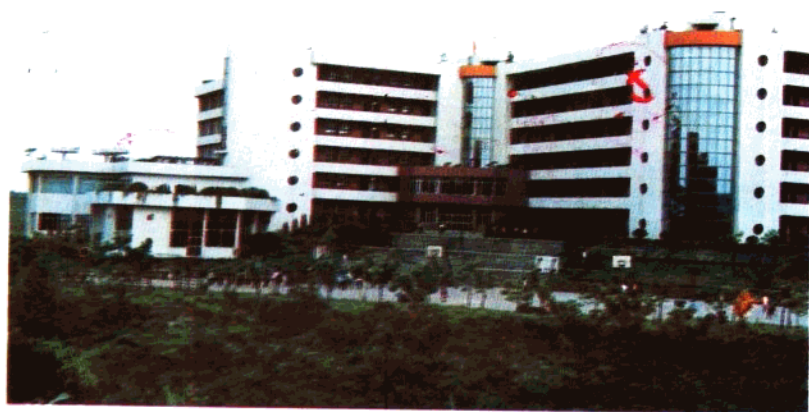
自贡职业大学教学大楼
