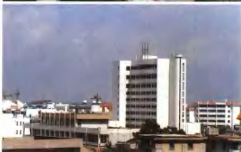
县一建公司承建的首优工程县农行大楼
