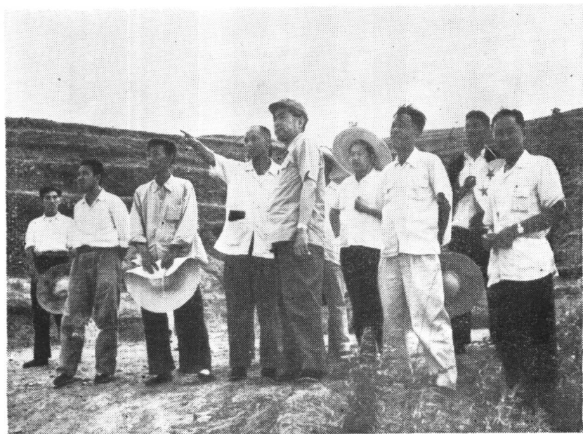
周总理踏勘密云水库坝址。
