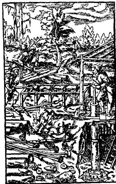
图 1.1 阿格里科拉的《冶金学》(1556 年)一书中所介绍的抽水机。左面那个人正在用螺旋钻掏空树干,制作管子
