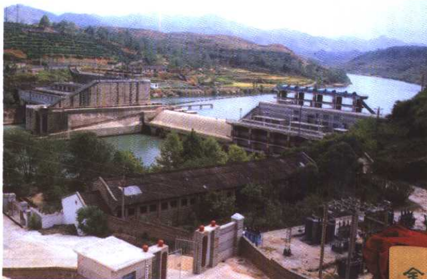
罗家寨水电站
