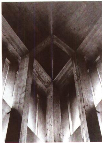
窗户、屋架与支撑的构造关系
