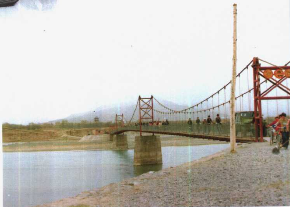
城北黄河吊桥
