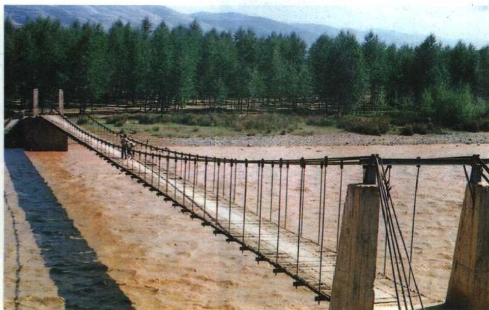
高庙断头崖湟水吊桥
