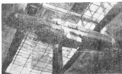
图 11 用 T 形铁件联结大柁与柱头
