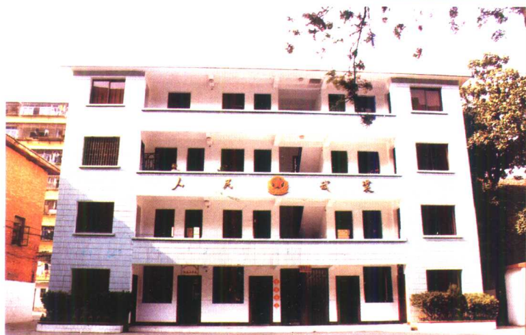
市人武部办公楼
