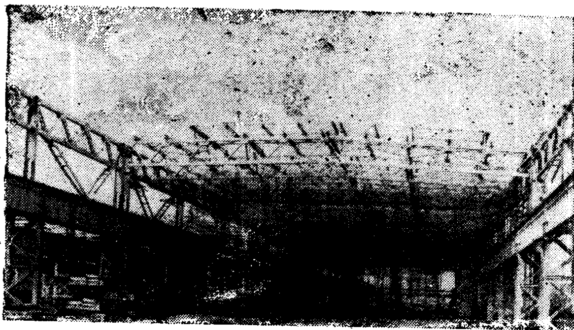
图 0-2 40 米跨度单层工业厂房
