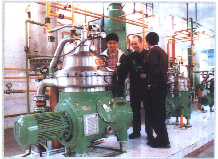
油化厂生产车间
