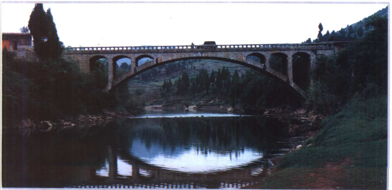
新建中渡大桥
