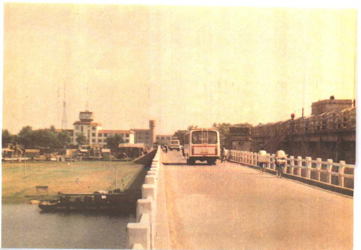
台儿庄运河大桥
