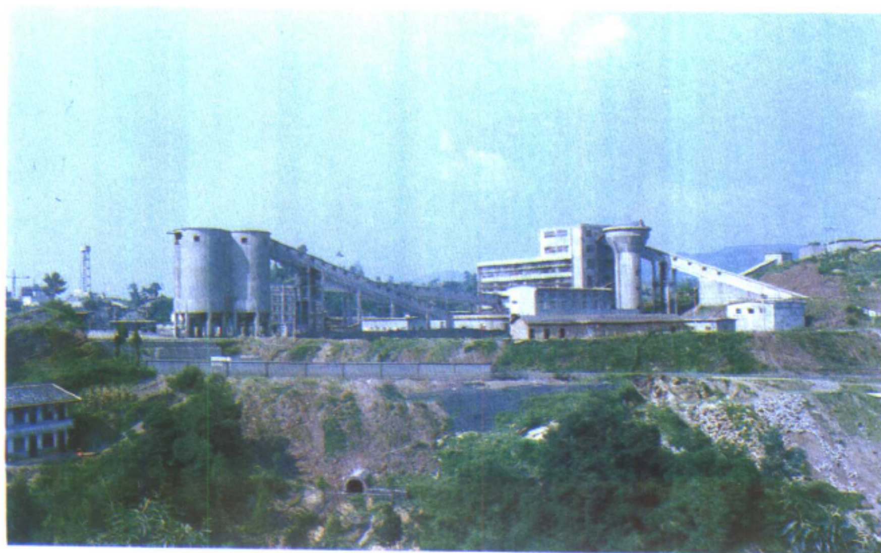
达竹矿务局石板选煤厂
