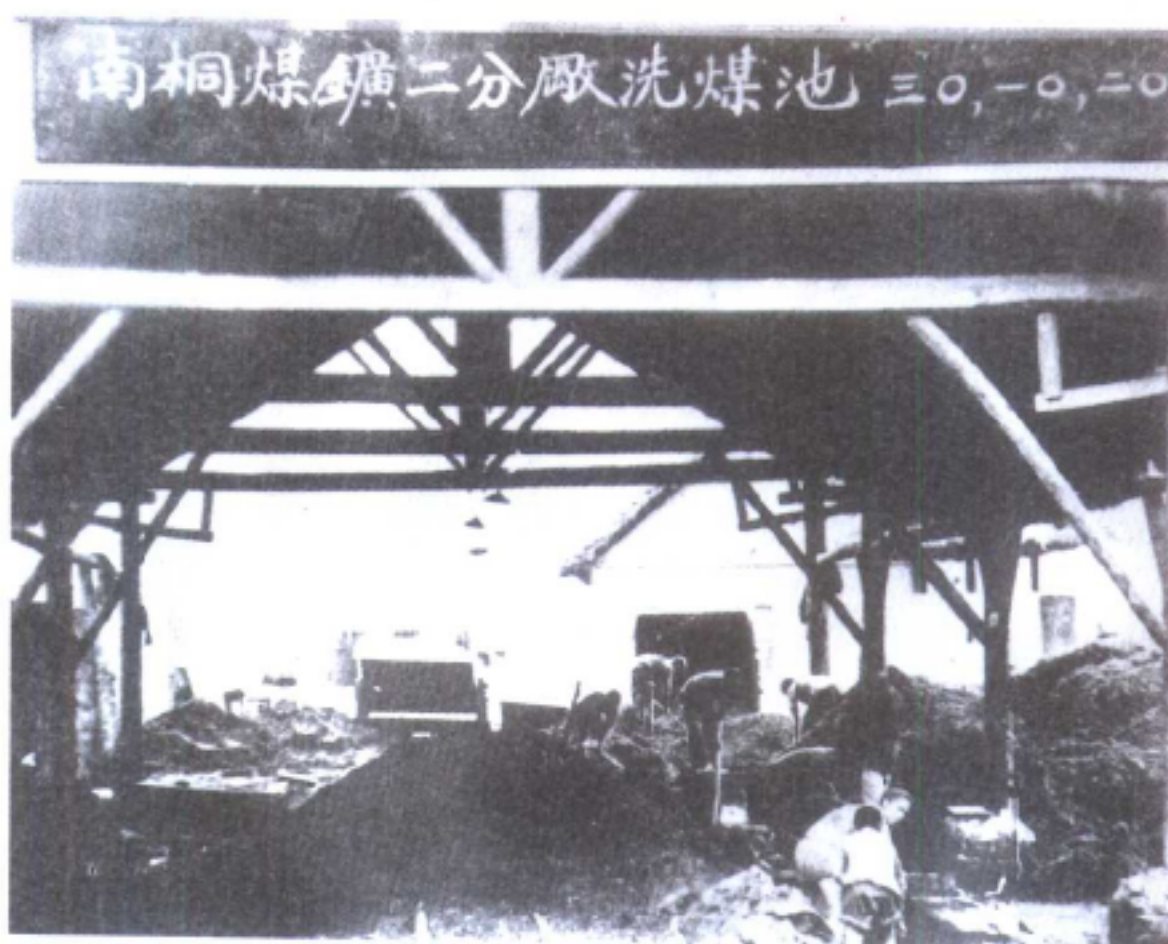
南桐煤矿洗煤池 (1941 年)
