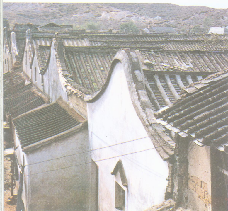
潮安古巷象埔寨内民居屋面
