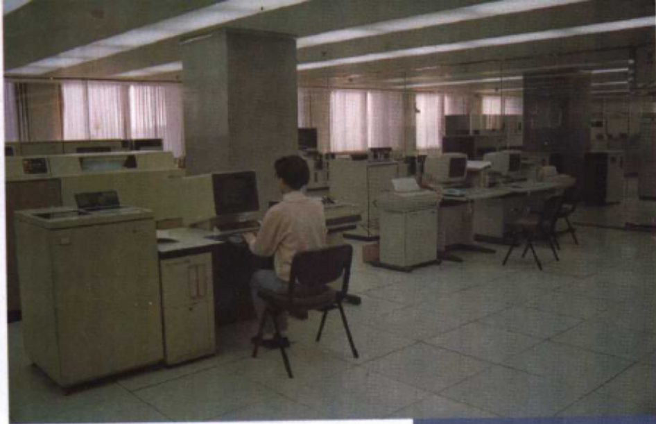
中国工商银行天津市分行 电脑部M-660H 机房
