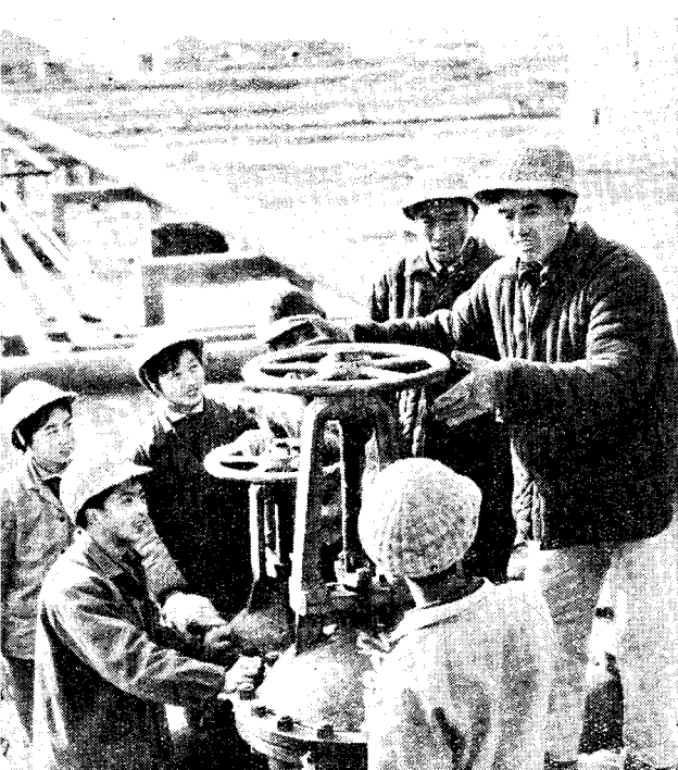
化工一厂油罐组的 工人正在向前来支援工 程建设的大庆工人学习 好思想、好作风
