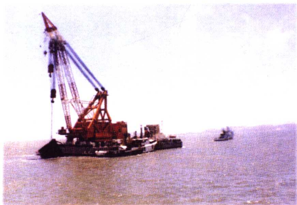
◀ “阿波丸”打捞工程暂告一段落。图为2500吨大型浮吊施工结束，正拖着沉船船头在回航中。
