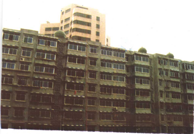
▲ 成都市中级人民法院干警住宅楼(1995年建)
