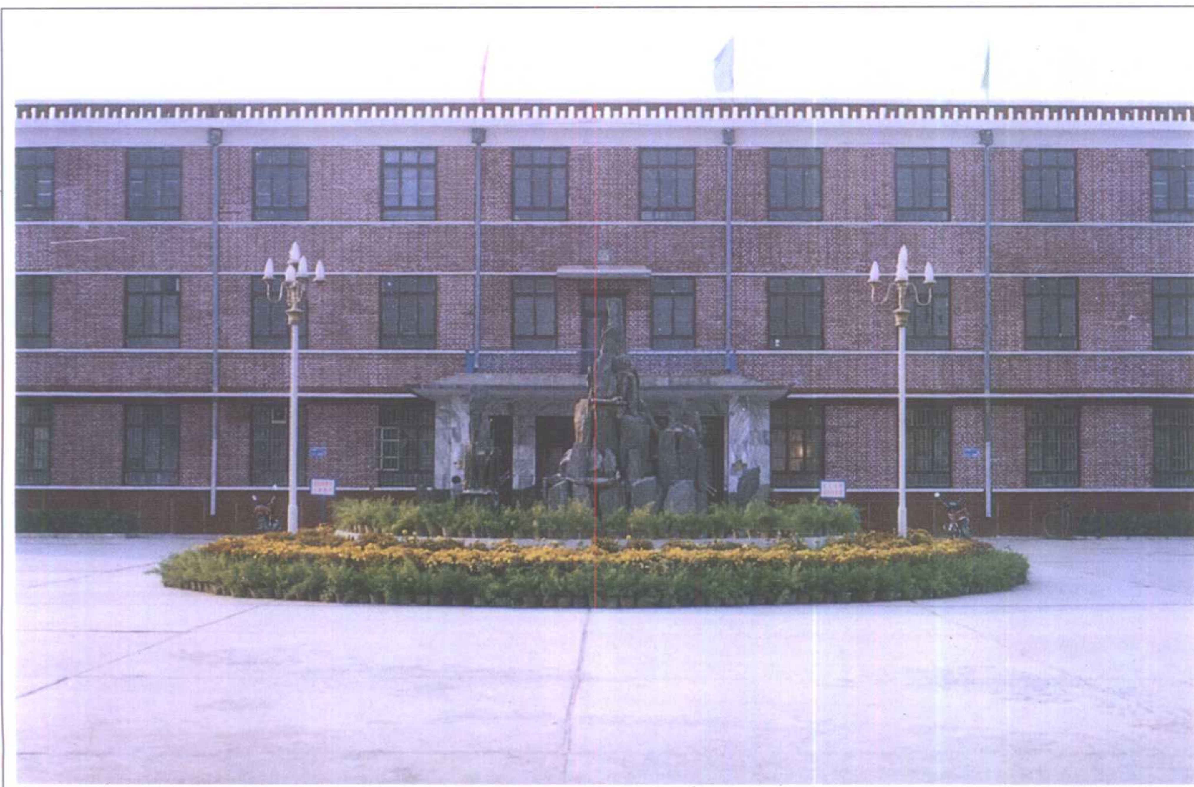
县委政府办公楼
