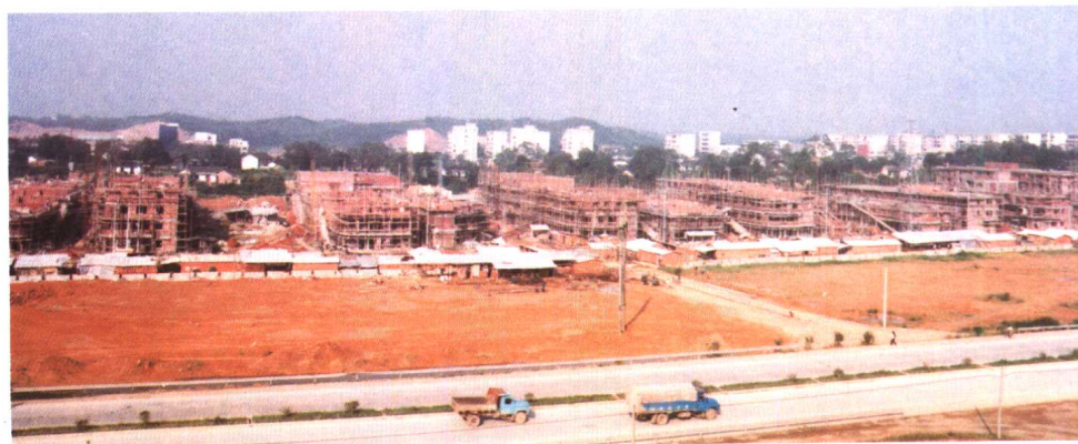
建设中的望城坡经济开发区
