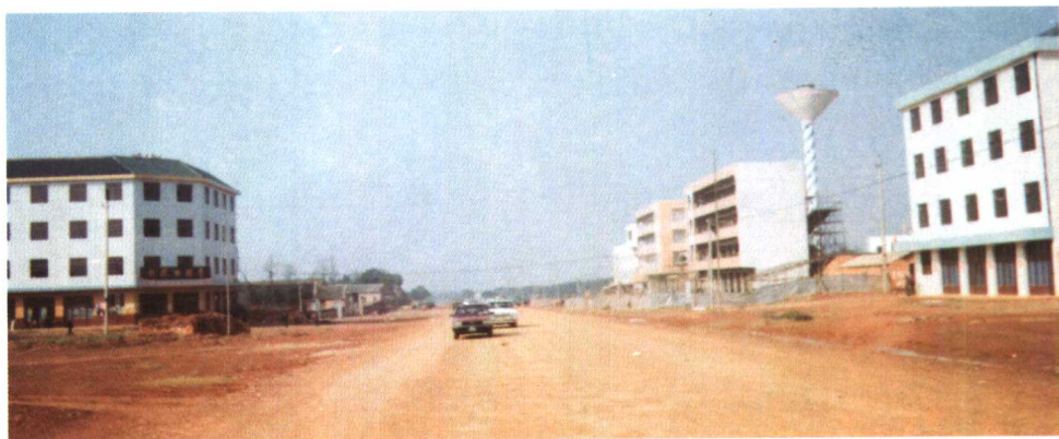
修建中的雷锋大道
