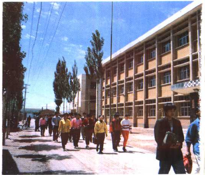
同心一中教学大楼
