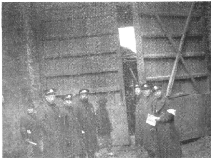
严密警戒的城门 在革命期间的数周内，武昌城门关闭。严格检查过护照后，笨重的铁门才打开一条仅容一人出入的缝隙放行。这幅照片显示了被黎将军特别召见的掩葬队的官员们，经过检查后，被容许出城的情形。
