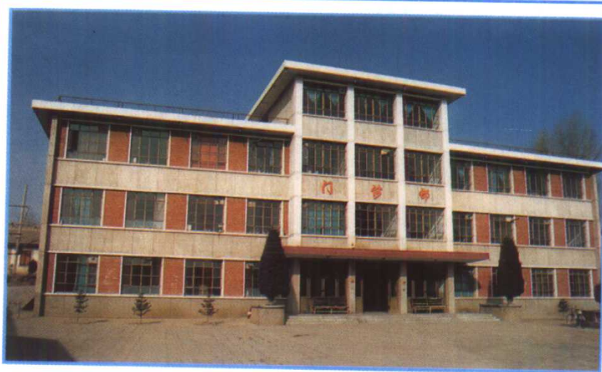
▲ 县医院门诊楼
