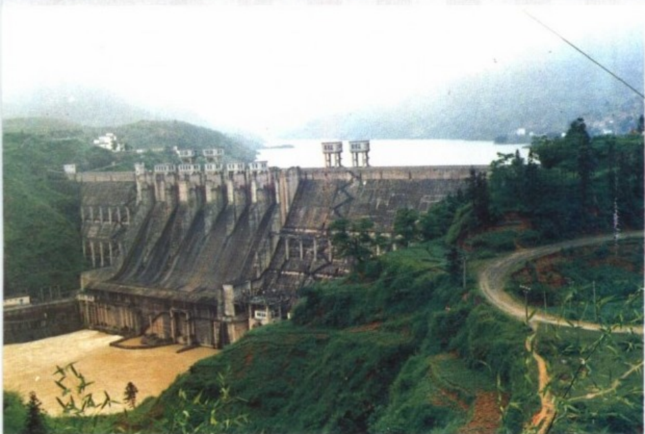
◁ 龙川枫树坝水电站
