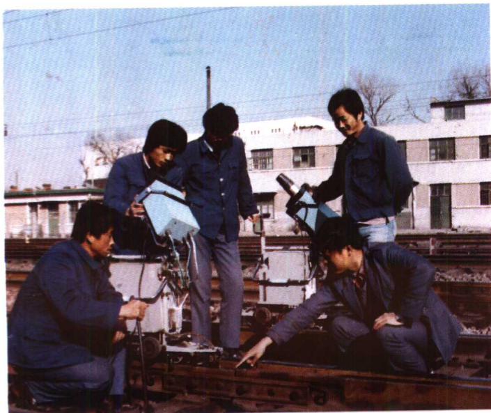
用超声波检查仪进行钢轨探伤检查
