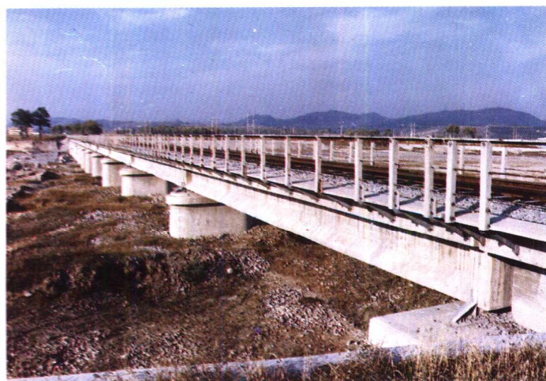
秦石地方铁路石河大桥
