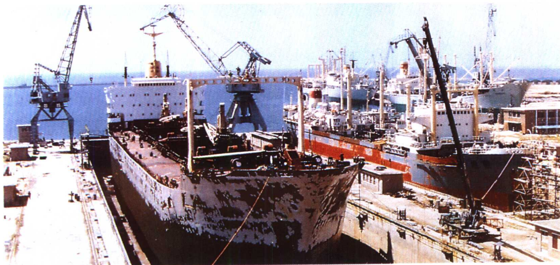
山海关船厂修船作业一角
