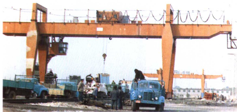
20 吨电动门式吊车正在作业
