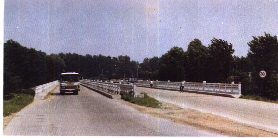
京哈公路海阳汤河桥
