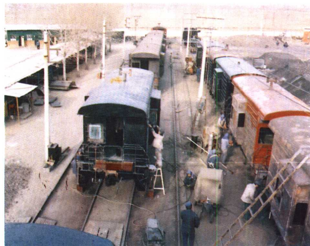
车辆段工人正进行修车作业
