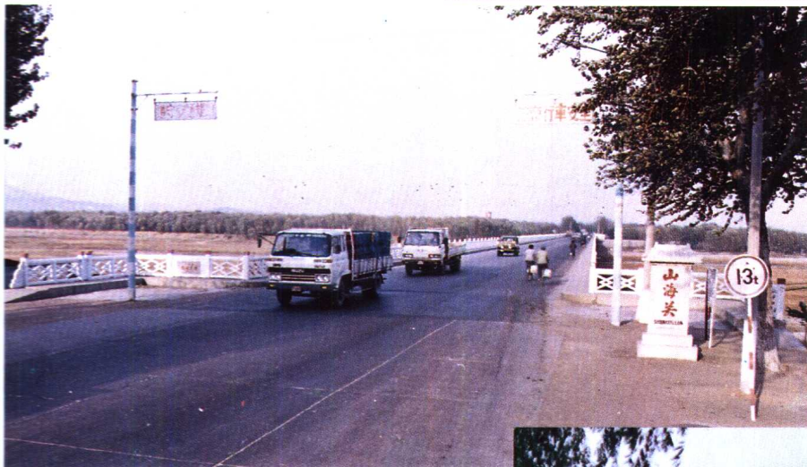
京哈公路山海关南园石河大桥
