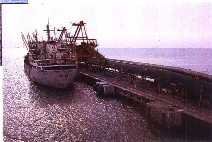
秦皇岛煤码头二期工程
