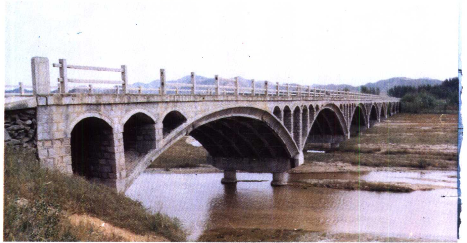
北界双公路双山子大桥
