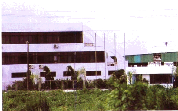
落户机场镇的“中日合资上海祭本自行车有限公司”厂址
