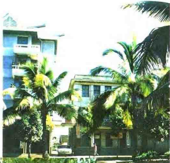
州商业局办公楼
