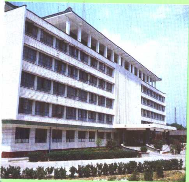
县建筑总公司承建的省全 优工程——县政府大楼
