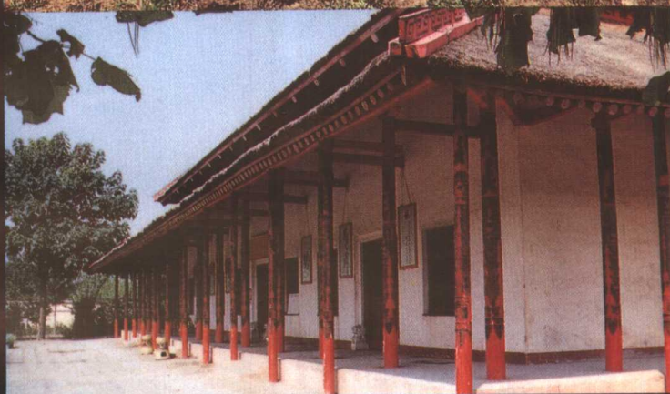
乙二十宫殿廊柱
