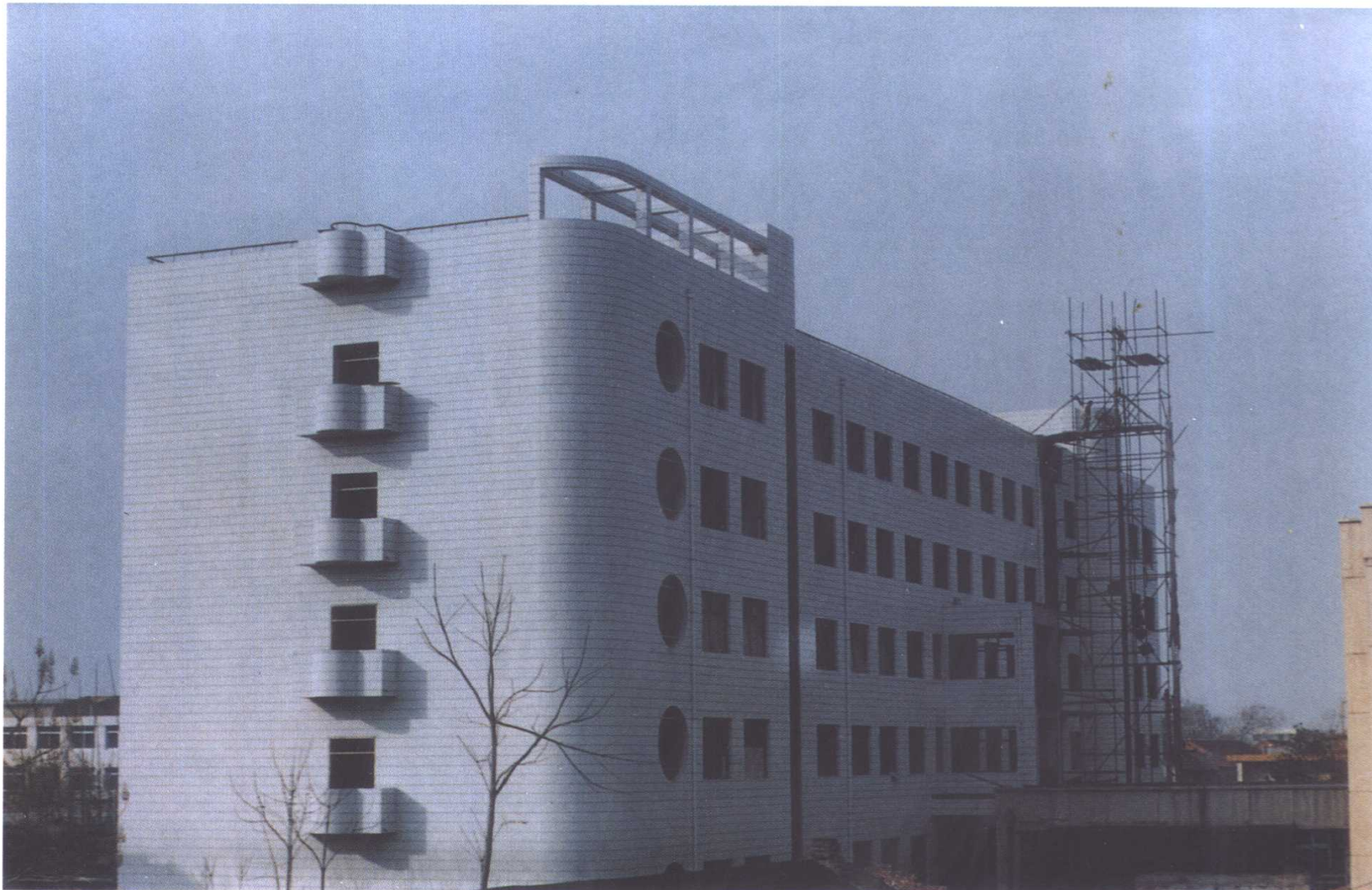
正在建设中的县医院病房楼
