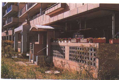
面向空地的住宅楼地下室部分
