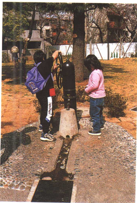
以手压泵汲取积存雨水流入小水沟
