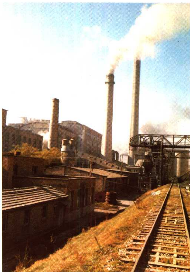
青海桥头发电厂
