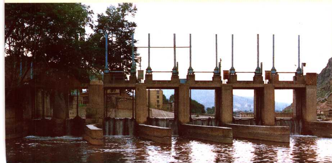
北川渠进水闸
