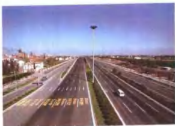
外环线一期工程(浦东段) (高建平 摄)
