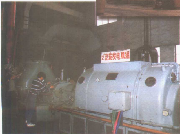
◀ 县火电厂汽 轮发电机组
