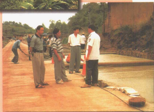
▲ 建设中的县城至泸州二级水泥公路
