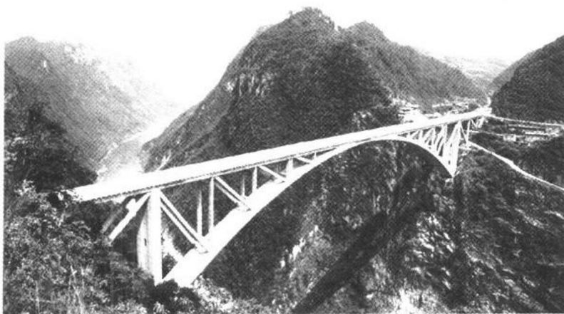
图 1-1 江界河大桥(主跨 330m)
