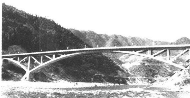
图 1-4 剑河大桥(主跨 150m)
