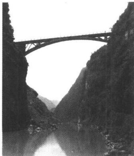
图1-2 长岩大桥(主跨75m)
