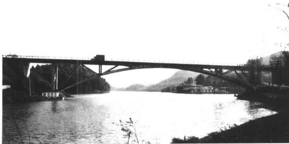
图 1-5 白马大桥(主跨 100m)
